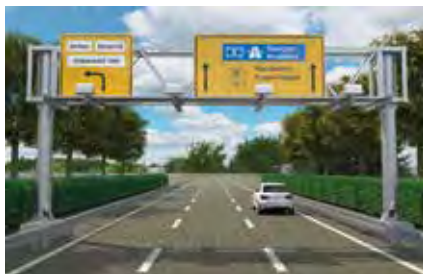
Portály dopravného značenia
