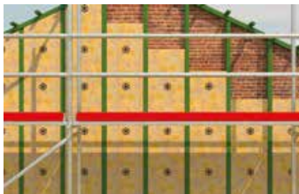
Izolačné materiály v prevetrávaných fasádach
