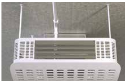
Závesné klimatizačné jednotky
