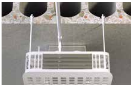
Vzduchotechnické jednotky montované k dutinovým panelom z predpätého betónu
