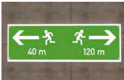
Značky núdzových východov v tuneloch
