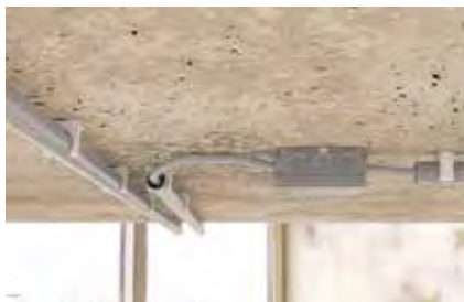
Upevnenie plastových izolačných trubiek
