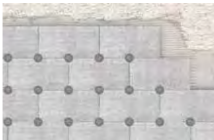
Zapustená montáž drevovláknitých dosiek na drevené konštrukcie
