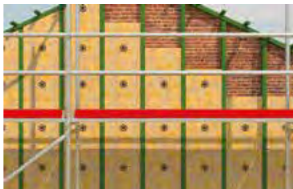
Izolačné materiály v prevetrávaných fasádach
