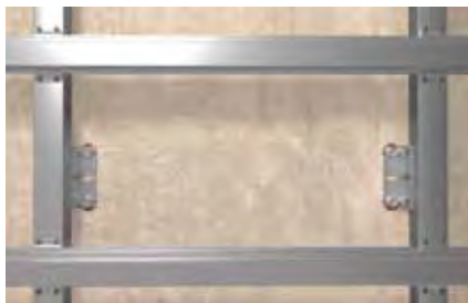
Kovová fasádna pod-konštrukcia
