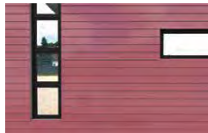
Nosné konštrukcie fasád
