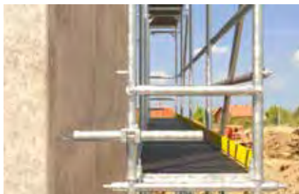
Kotvenie fasádneho lešenia
