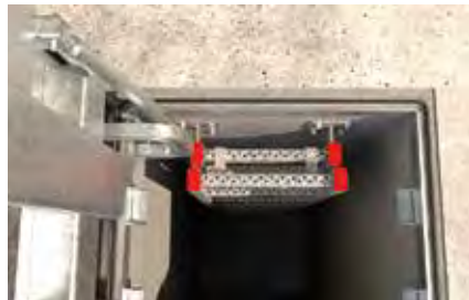
Vstup do prepadovej dažďovej nádrže
