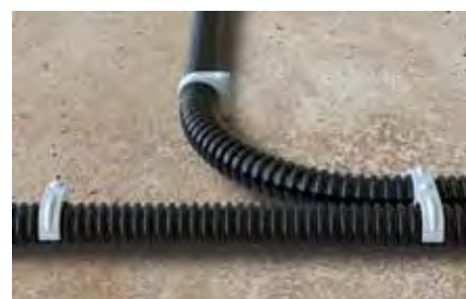
Upevnenie flexibilných trubíc
