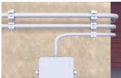
Upevnenie káblových trás
