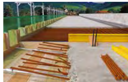
Vlepované betonárske výstuže
