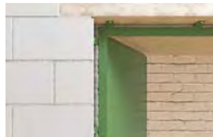
Vyplňovanie dutín v izolácii
