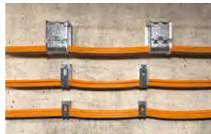
Upevnenie kábla na stenu
