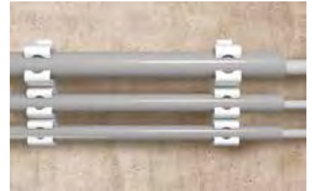
Upevnenie plastových izolačných trubiek
