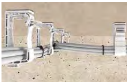
Zväzovanie elektrických káblov
