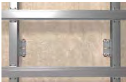
Nosné konštrukcie fasád
