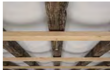
Stropné spodné konštrukcie
