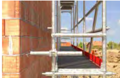
Kotvenie fasádneho lešenia
