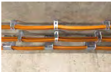
Upevnenie kábla na strop
