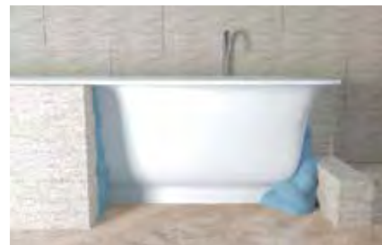
Izolácia kúpeľňových vaní a sprchovacích kútov
