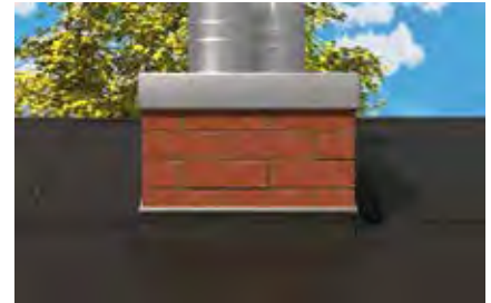
Tesnenie striech s asfaltovými izolačnými pásmi
