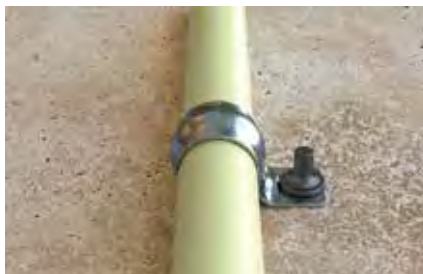
Ukotvenie opláštených trubiek
