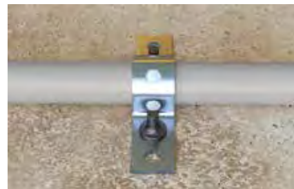
Ukotvenie dierovaných pásov
