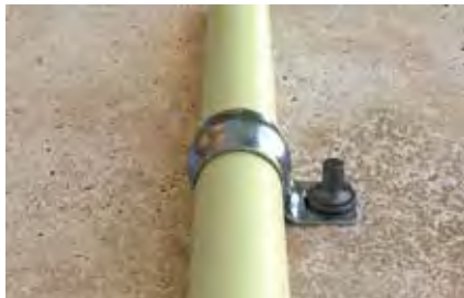
Upevňovanie oplástených trubiek
