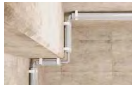
Upevnenie plastových izolačných trubiek
