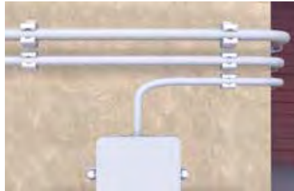
Upevnenie káblov
